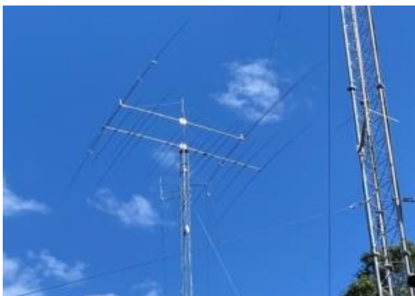
Toren 1 van de Tampa Amateur Radio Club, met de Force 12 C31XR antenne, tweede van boven. [Foto van Lu Romero, W4LT]
